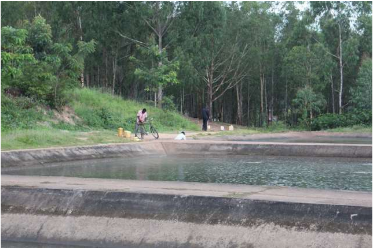
due vasche di filtraggio lato destro
